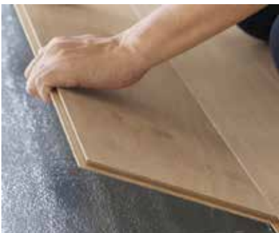
接着剤・釘が不要の施工方法
