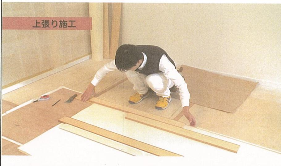
無地物の材料は、スミ打ちをして寸法を出します。このように中央部分でも寸法を確認することを忘れないでください。また、裁ち方は、スミの内側で正確に切り落とします。
