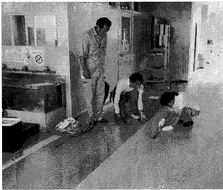
学校校務士へ長尺塩ビシート 溶接工法を講習
