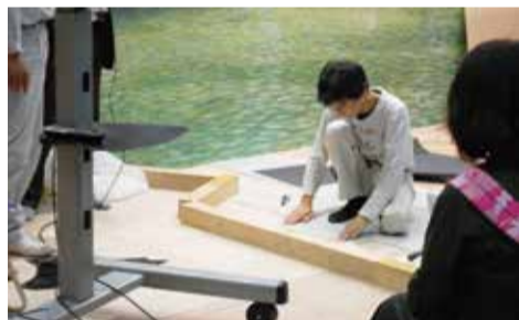
プラスチック床材施工（塩ビタイル）
