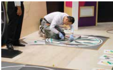
プラスチック床材施工（メダリオン柄施工）
