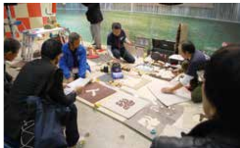
カーペット施工（文字はめ込み）
