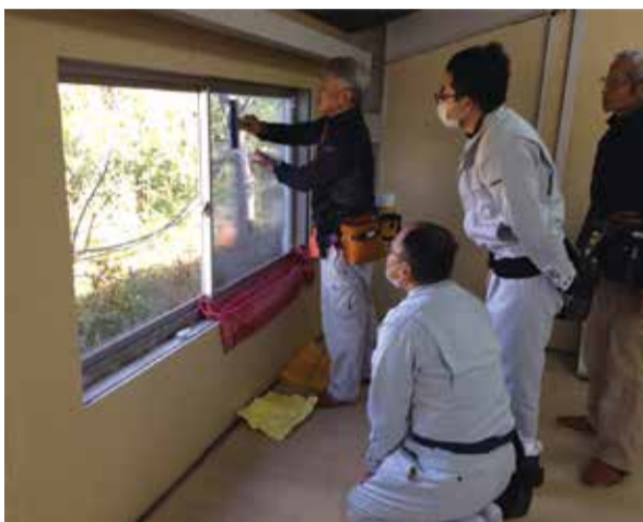
ガラスフィルム施工の実習
