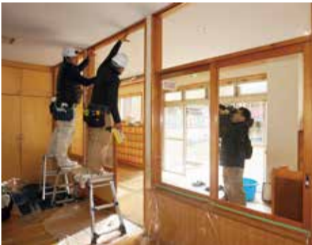
青年部会のボランティア活動。幼稚園にガラスフィルムを施工
